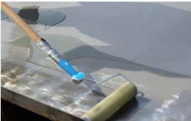
图2: 粘结剂施工
