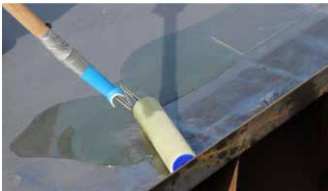
图8: 打底漆施工
