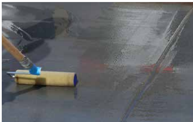
图2: 打底施工
