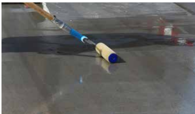
图9: 打底施工
