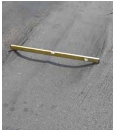
Spurbildung unter zunehmendem Schwerverkehr und erhöhten Achslasten
