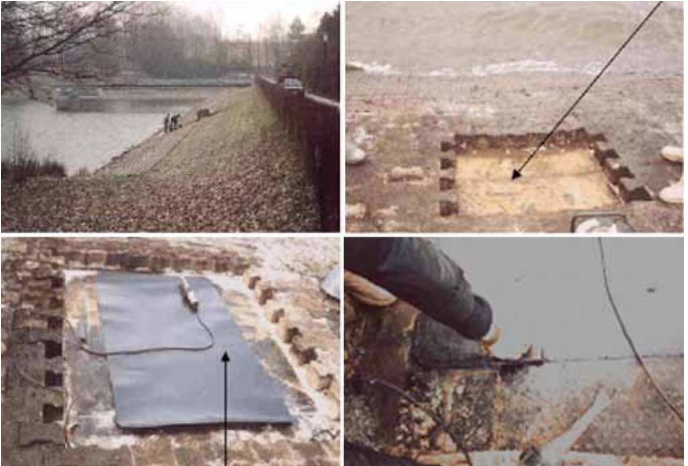
图像14: 在密封“堤岸大坝Kell”上,材料试样的抽取和随后用热气焊的方法密封洞,2004年
